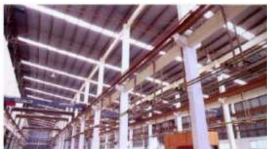
Hình 17. Chiếu sáng tự nhiên bằng mái checacbonat tổng hợp
