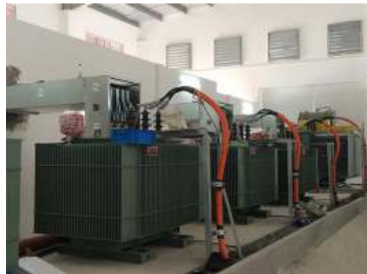
Hình 10. Máy biến áp trong hệ thống cung cấp điện
