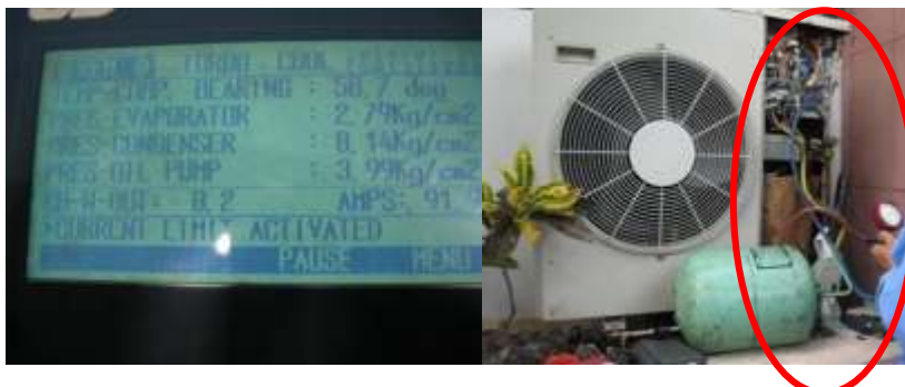
Hình 57. Hình ảnh thu thập dữ liệu hoạt động của hệ thống ĐHKK
