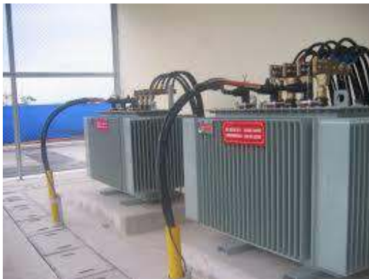
Hình 10. Máy biến áp trong hệ thống cung cấp điện
