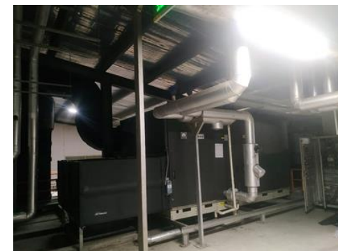
Hiện trạng của hệ thống cũ
