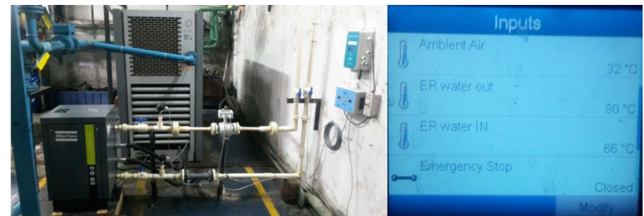
Hình ảnh thực tế lắp đặt bộ thu hồi nhiệt
